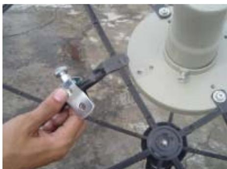
3. นำชุดยึดก้านพืดของ LNB KU มาใส่เข้ากับก้านพืด
