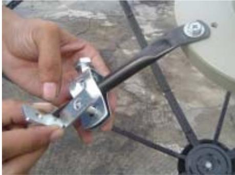
7. นำเหล็กฉาก L มาประกอบกับชุดยึดก้านพีดี
